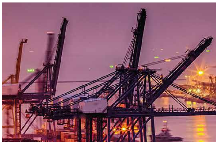
Grúas y montacargas
